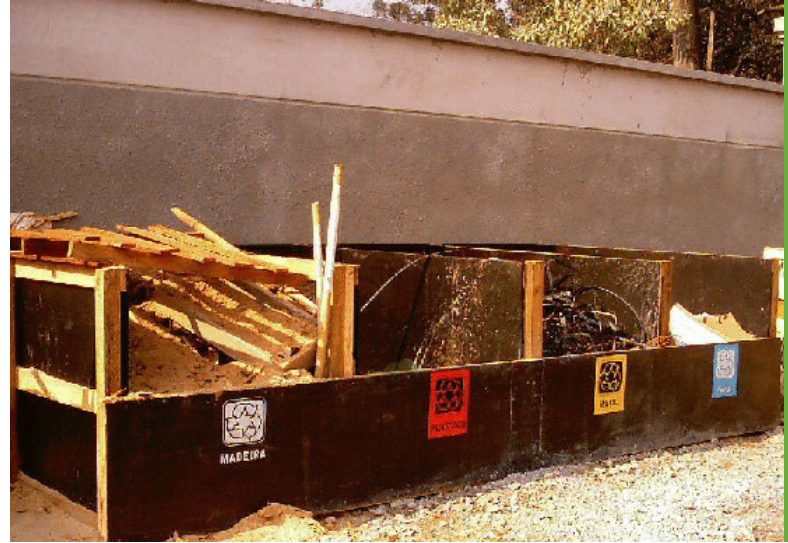
Segregación en obra, con sus limitantes de espacio, transporte y otros
